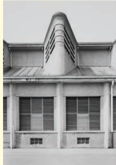
TIROL JENBACH ACHENSEEKRAFTWERK 1989
